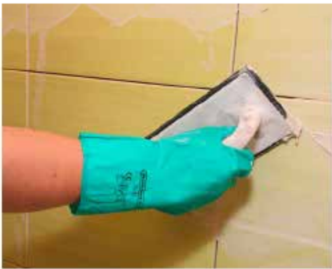
9 Égetett kerámia fugázása Sopro DF 10 ® -zel.
