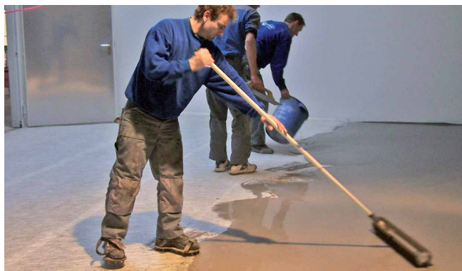
UZIN NC 170 LevelStar öntése a leterített UZIN RR 201 renováló filcre.
