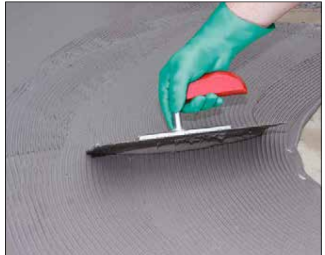
10 A Sopro TurboDichtSchlämme 2-K felhúzása 4 mm-es fogaztú glettvassal az előnedvesített vagy lealapozott aljzatra.
