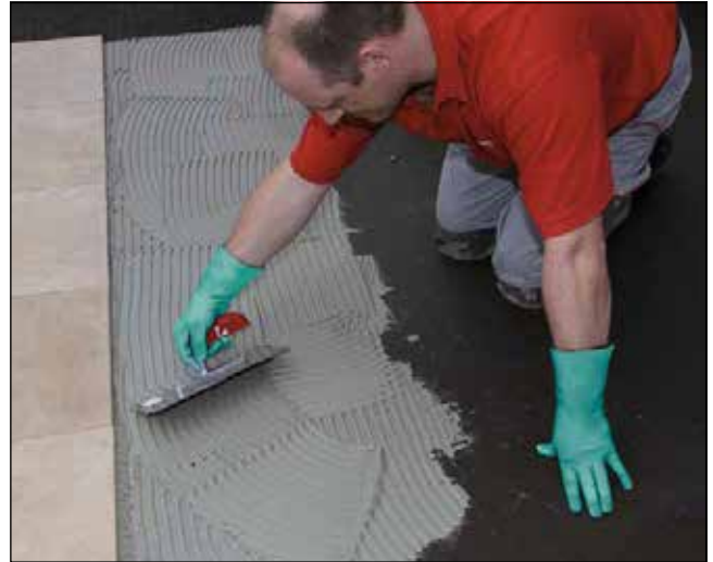
16 A kétkomponensű Sopro flexibilis ragasztók, például a Sopro megaFlex S2 vagy a Sopro megaFlex S2 turbo felhordása a kikeményedett szigetelésre
