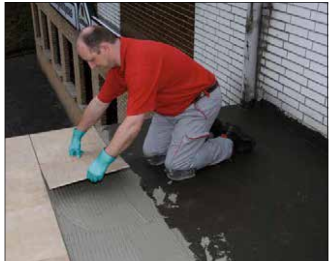
18 A burkolólap behelyezése és beigazítása a friss ragasztóágyzatba.
