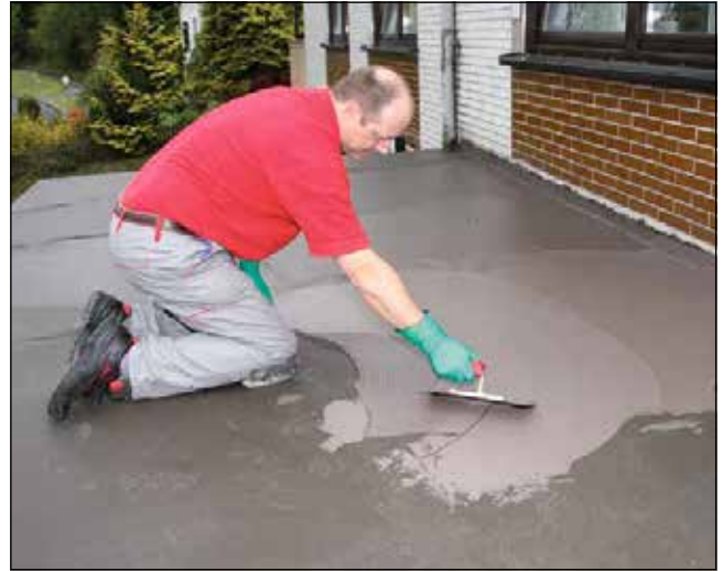
14 A 2. réteg felhordása a 2 órája száradó 1. szigetelő rétegre...
