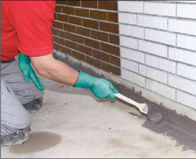
7 A lábazatra felkenjük a Sopro TurboDichtSchlämme 2-K-t...
