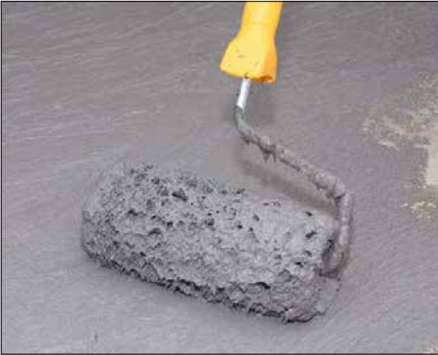
13 A Sopro TurboDichtSchlämme 2-K feldolgozása történhet bárány-szőr hengerrel is.
