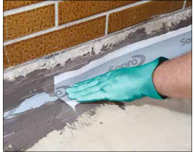
8 ... hogy a lefektetett Sopro Dichtband-ot rögzíthessük. Nyomkodjuk bele az anyagba.
