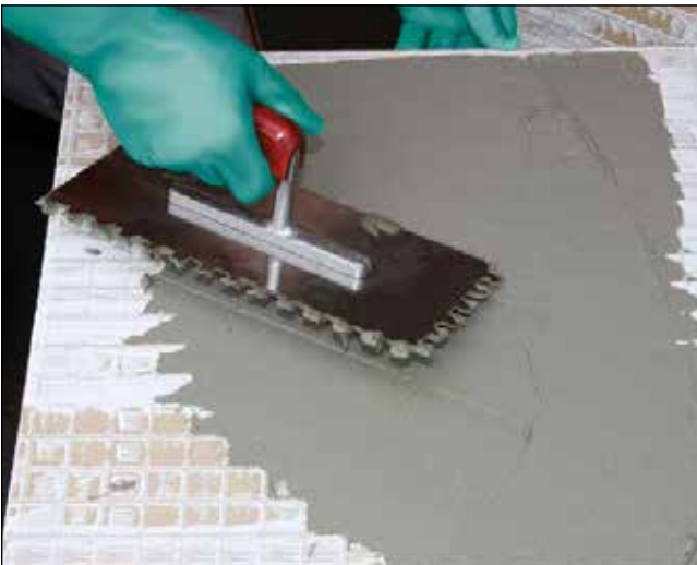
17 Az "úsztatott" eljárás használata a burkolólap méretétől és hátuljának tulajdonságaitól függ, és a teljes felületen történő ragasztást szolgálja.
