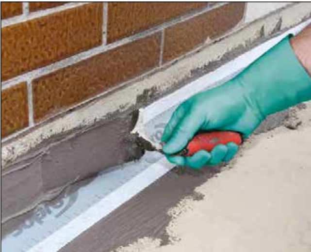
9 Dolgozzuk át a Sopro Dichtband-ot Sopro TurboDichtSchlämme 2-K-val.
