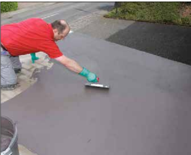
11 A Sopro TurboDichtSchlämme 2-K elsimítása glettvassal.
