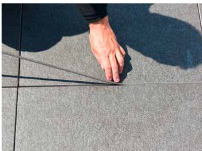
9. A tervezett dilatációs fugákat töltsék ki fugakörprofillal, hogy megakadályozzák a három oldali letapadást.
