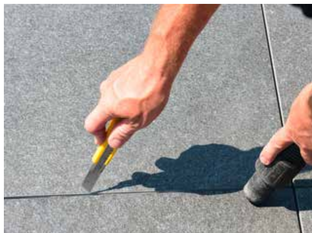
8. Tisztítsák ki alaposan a fugahézagokat, és távolítsák el az anyagmaradványokat.
