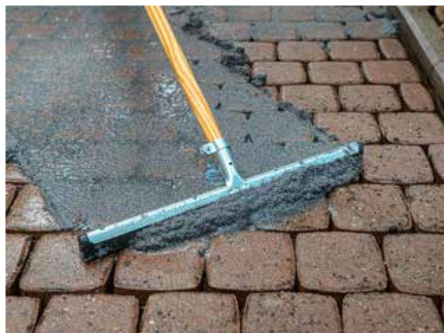
Térkövek felújítása Sopro Solitär® F20-szal.
