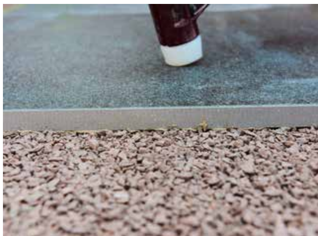
7. Fektessek le a lapokat és enyhe ütögetéssel igazítsák a helyükre.
