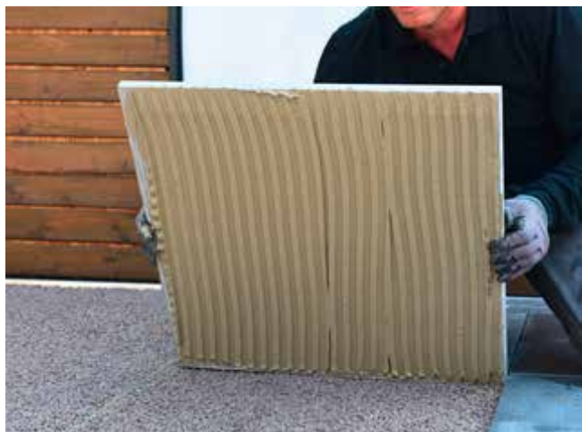
5. A \geq 2 cm vastagságú kerámia terasz burkoló lapokat úsztatott eljárással fektetjük. A lapok hátoldalára 10 mm-es fogazatú glettvassal húzzuk fel a Sopro csemperasztót, pl. No 101 S1.
