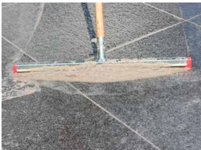
13. ... majd gumi behúzóval dolgozzák be a fugahézagba!
