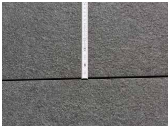
6. Tartsák be a minimum 3 mm-es fugaszélességet!
