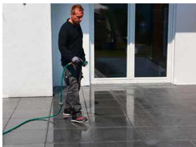
10. A fugázás előtt a teljes felületet be kell nedvesíteni, és folyamatosan nedvesen kell tartani.
