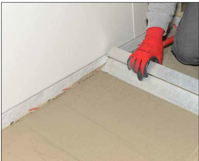
5 Lejtés kialakítása simítóléccel.
