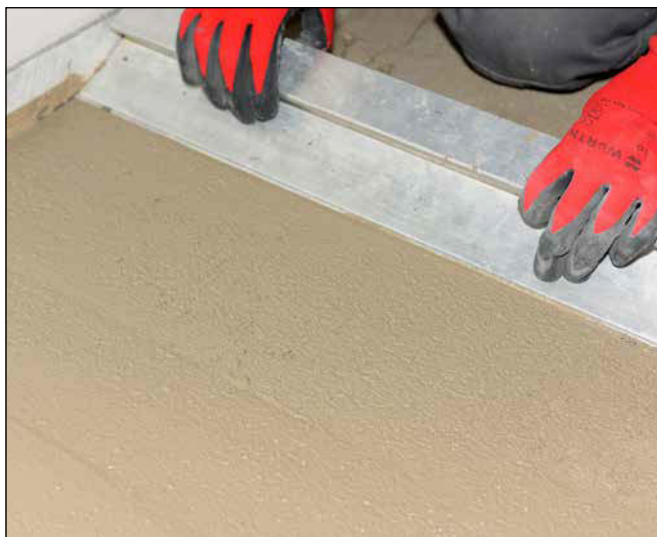
6 Az anyag öntömörödő képességének köszönhetően egyenletes és sík felület alakítható ki.
