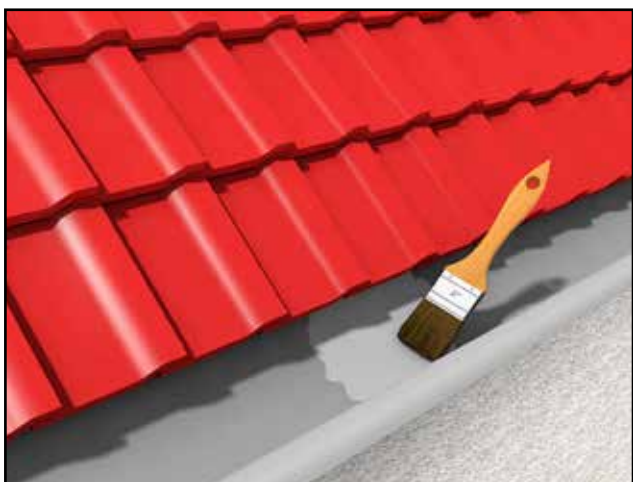
3) Ereszcsatornák tömítése és javítása.
