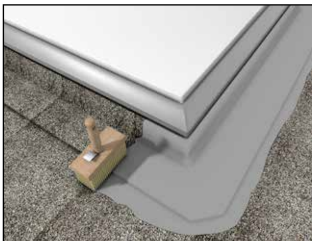
4) Tetőn átfedések tömítése és lezárása.
